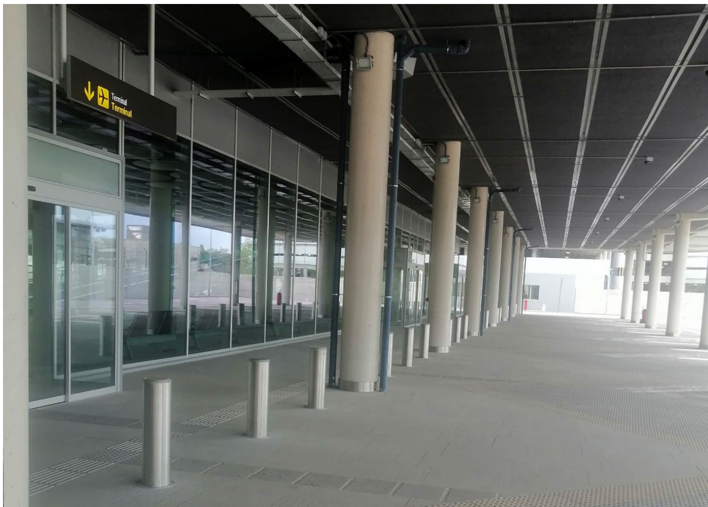
INOX FISSO Ø220 H1200 HS1200 TELESCOPICA AUTOMATICA Ø220 x 600mm H6008
