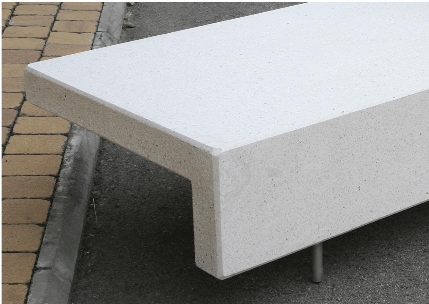
Le **béton** est un produit résultant du mélange d'un liant (généralement ciment, sable, gravier ou pierre concassée et eau) qui, en durcissant acquiert une résistance similaire à celle des meilleures pierres naturelles.
